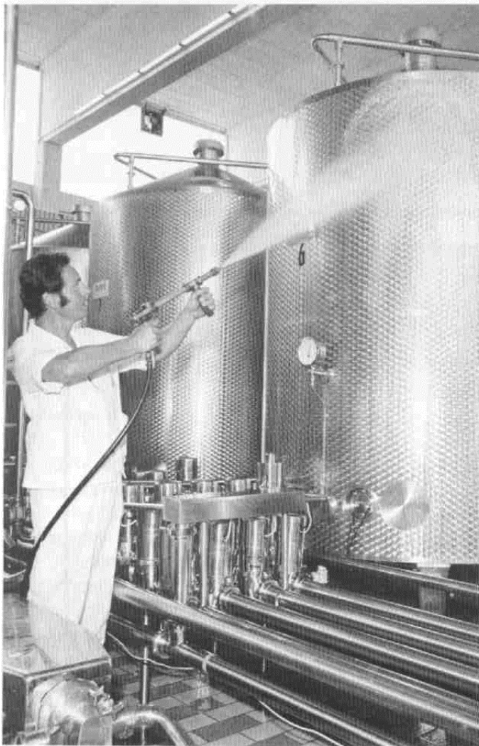
Hochdruckreinigung von Edelstahltanks
