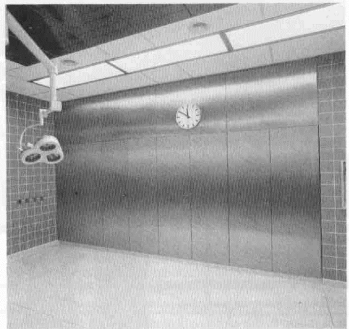
Einbauwand aus Edelstahl Rostfrei in einem Operationssaal: Auch in der reflexmindernden, matten Oberflächenausführung bleiben die günstigen Voraussetzungen für die Flächendesinfektion erhalten
