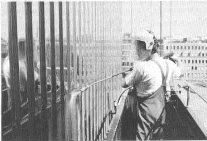
Grundreinigung einer Edelstahl-Rostfrei-Fassade nach nahezu 40 Jahren in Großstadtatmosphäre
