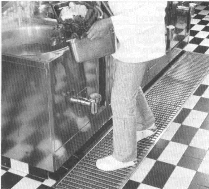
Verschmutzungen lassen sich von Rosten aus Edelstahl Rostfrei durch Wasserstrahlreinigung oder in der Spülmaschine leicht entfernen
